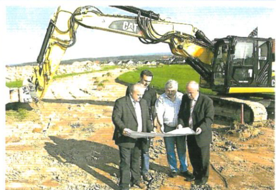
Die beiden Bürgermeister Siegfried Böhringer (rechts) und Johann Dechant (links) sowie der Vorsitzende des Zweckverbandes zur Abwasserbeseitigung, Fritz Dechant, und Ingenieur Christian Kotschate besichtigten die Straßenbaustelle im neuen Baugebiet „An der Hohenwarther Straße“ in Steinsberg. Foto: Merl
