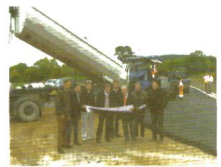
Im Regenerungsbereich Regenstauf (L) sind weitere Investitionen für Platten- und Plattenbauarbeiten für die Straßengestaltung im neuen Gewerbe- und Wohngebiet.
