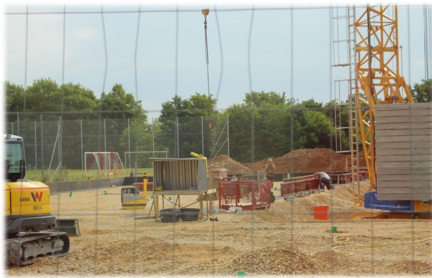
Baustelle KITA Steinsberg
